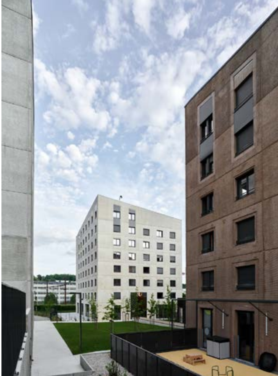
Terrasse de la crèche
